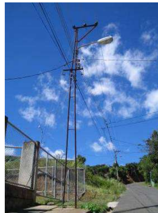
Figura 78: Poste eléctrico en San Rafael
