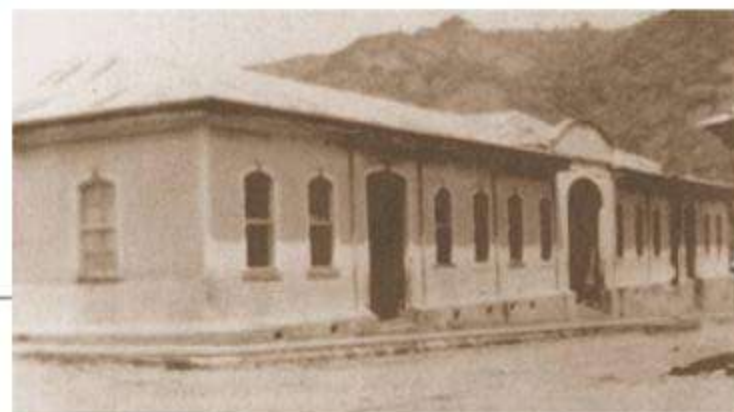
Foto de la Escuela Central de Tres Ríos luego de su reconstrucción.
