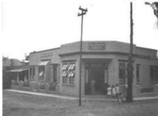
La Unidad Sanitaria en el año 1938. Fuente: Rockefeller Archive Center, serie 313J, n°25093
