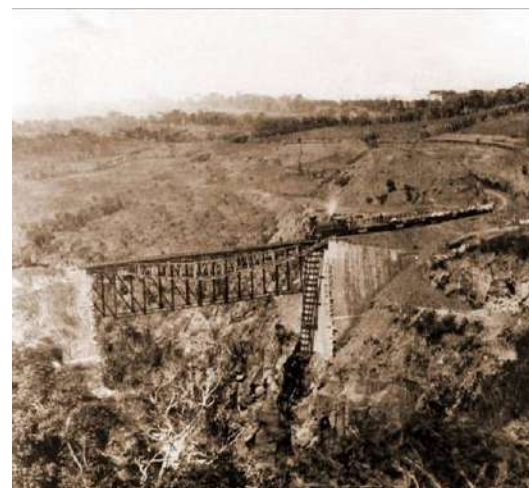
Figura 56: Puente sobre la Quebrada del Fierro, año 1873
